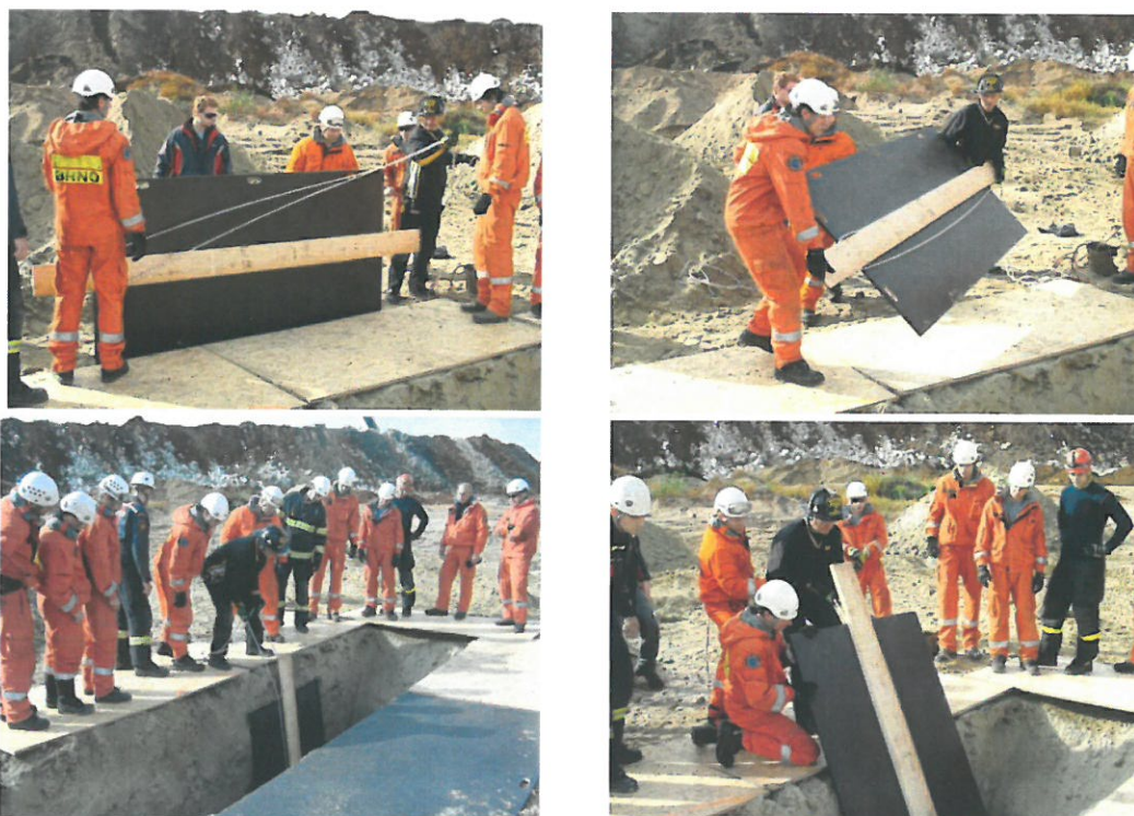
Obrázek 26, Umístění bednicí desky do výkopu pomocí lanové smyčky [5]
