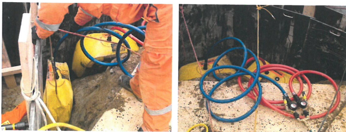
Obrázek 56, Vyplnění defektu vnitřního rohu výkopu pomocí nízkotlakých vaků [5]
