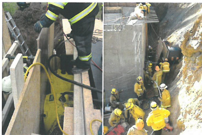
Obrázek 19, Použití nízkotlakých a středotlakých vaků u zásahu [5,6]
