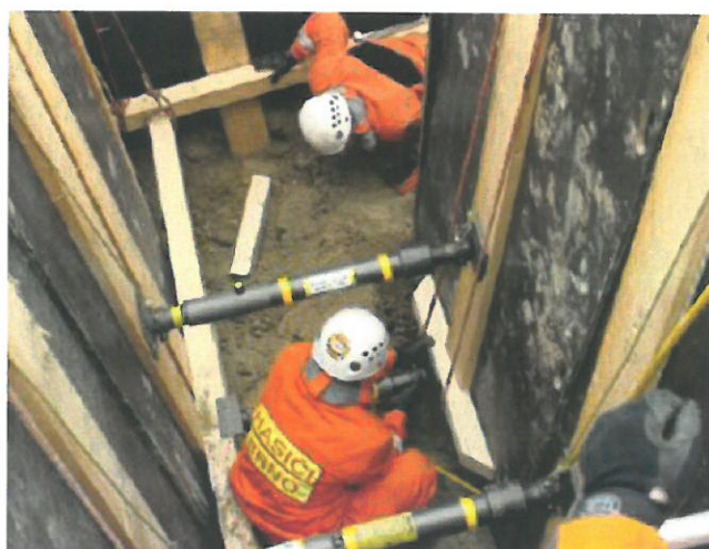
Obrázek 55, Nasazení dvou příslušníků v zabezpečené oblasti rohového výkopu [5]
