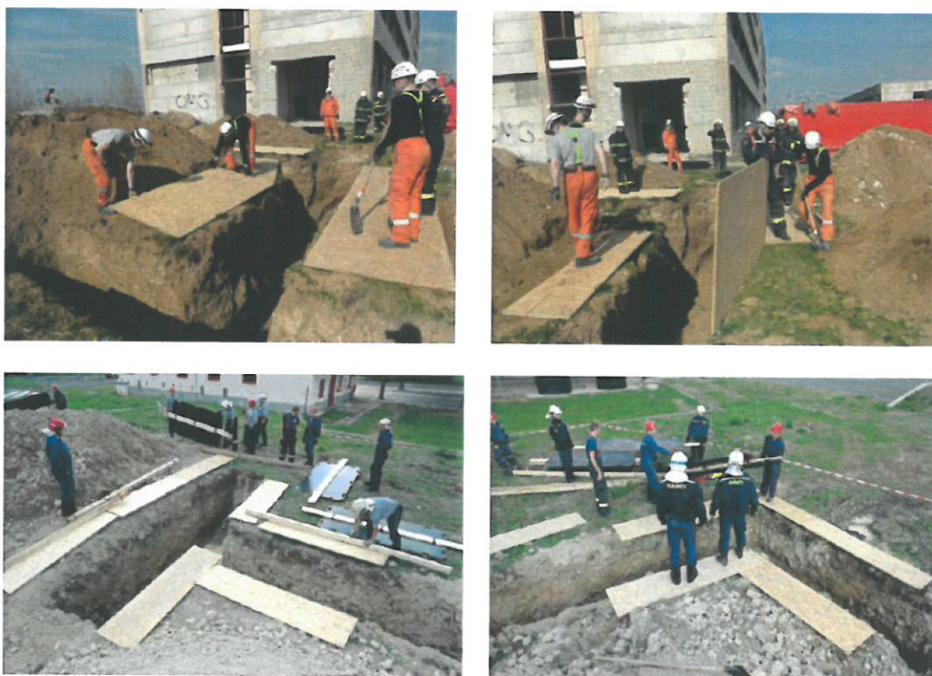
Obrázek 25, Ukázky správného rozložení váhy na hraně výkopu položením nášlapných desek [5], [8]
