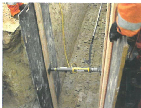
Obrázek 33, Nasazení středové stabilizační tyče do bednicí desky [5]
