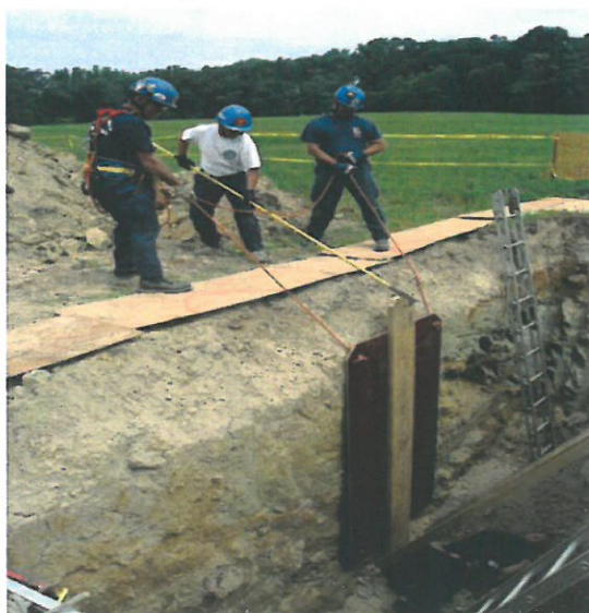
Obrázek 27, Spouštění bednicí desky do výkopu pomocí trámů [1]
