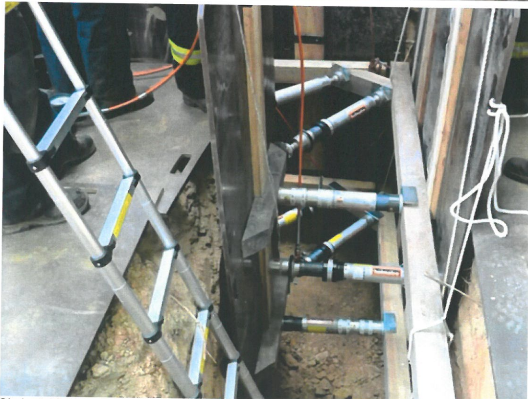
Obrázek 60, Konečná fáze stabilizace rohového výkopu pomocí stabilizačních tyčí HOLMATRO
