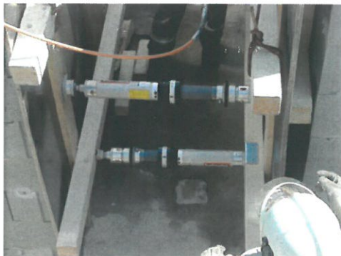
Obrázek 33, Nasazení středové stabilizační tyče do bednicí desky [5]
