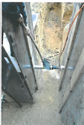
Obrázek 35, Způsoby uvolnění automatické pojistky pneumtické tyče bez vstupu do výkopu [7]
