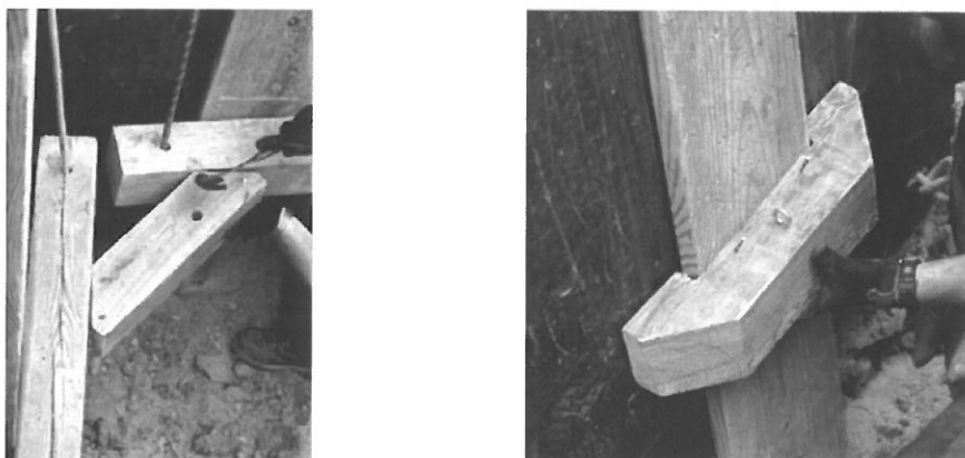
Obrázek 10, Nasazení dřevěných prvků při stabilizaci rohových výkopů [6]
