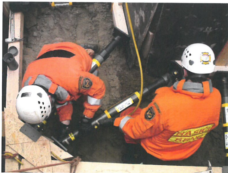
Obrázek 58, Umístění šikmých tyčí v rohovém výkopu [5]
