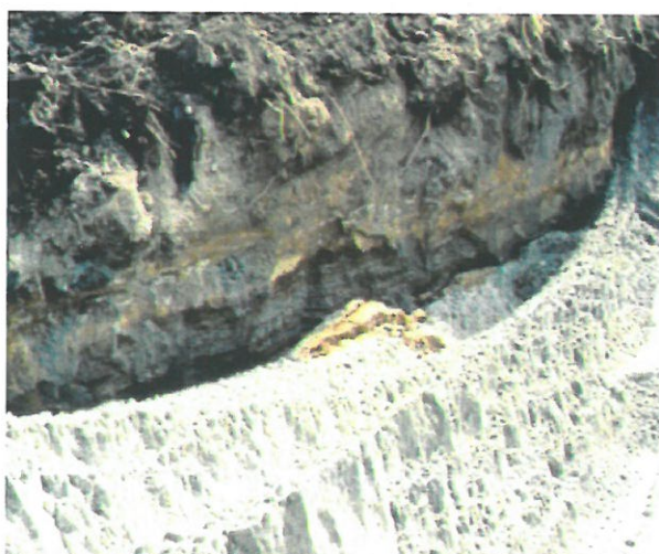
Obrázek 5, Ukázka skladby vrstev podloží [6]
