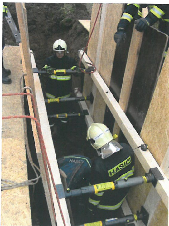
Obrázek 43, Nasazení vnitřních trámů zajišťuje možnost hlubokého kopání [5]
